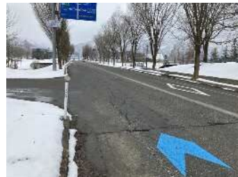
消雪パイプ設置路線
