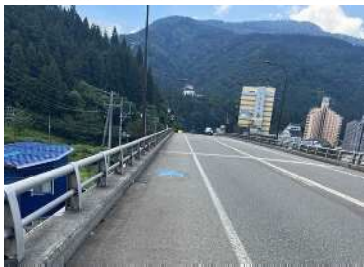
矢羽根型路面表示の設置
