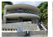
【サイクルステーション】 飲食や充電ができ、修理器具の貸し出し等も行う休憩施設を整備
